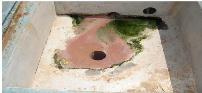
**Figure 36** : Prolifération des algues au niveau du boîtier de contrôle.
