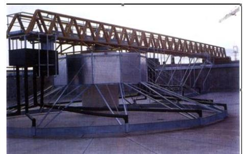
Fig.2.6 : Décanteur à succion annulaire de ROANNE (Loire), Q:30000m<sup>3</sup>/j.
