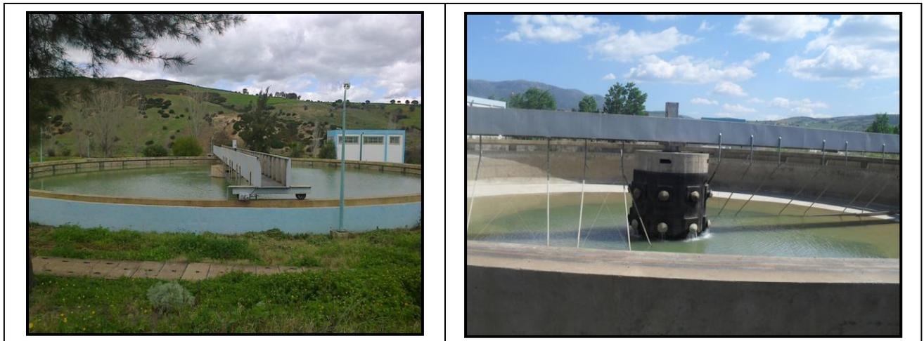
Figure 3.14 : Décanteur de la station de traitement de Guelma
