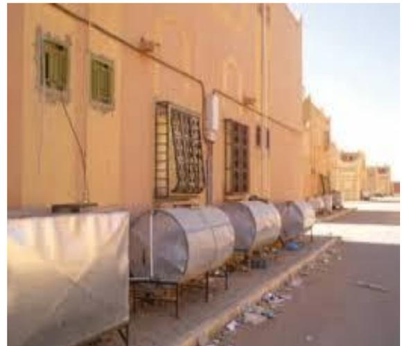
**Photo 3.5.** Réservoirs de stockage pour l'eau potable
