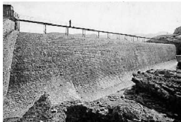
**Figure 14. 1.** Barrage de Fergoug en 1907 après reconstruction
