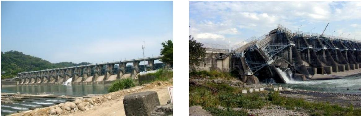
**Figure 12. 1.** Le barrage de Shih-Kang avant et après sa rupture
