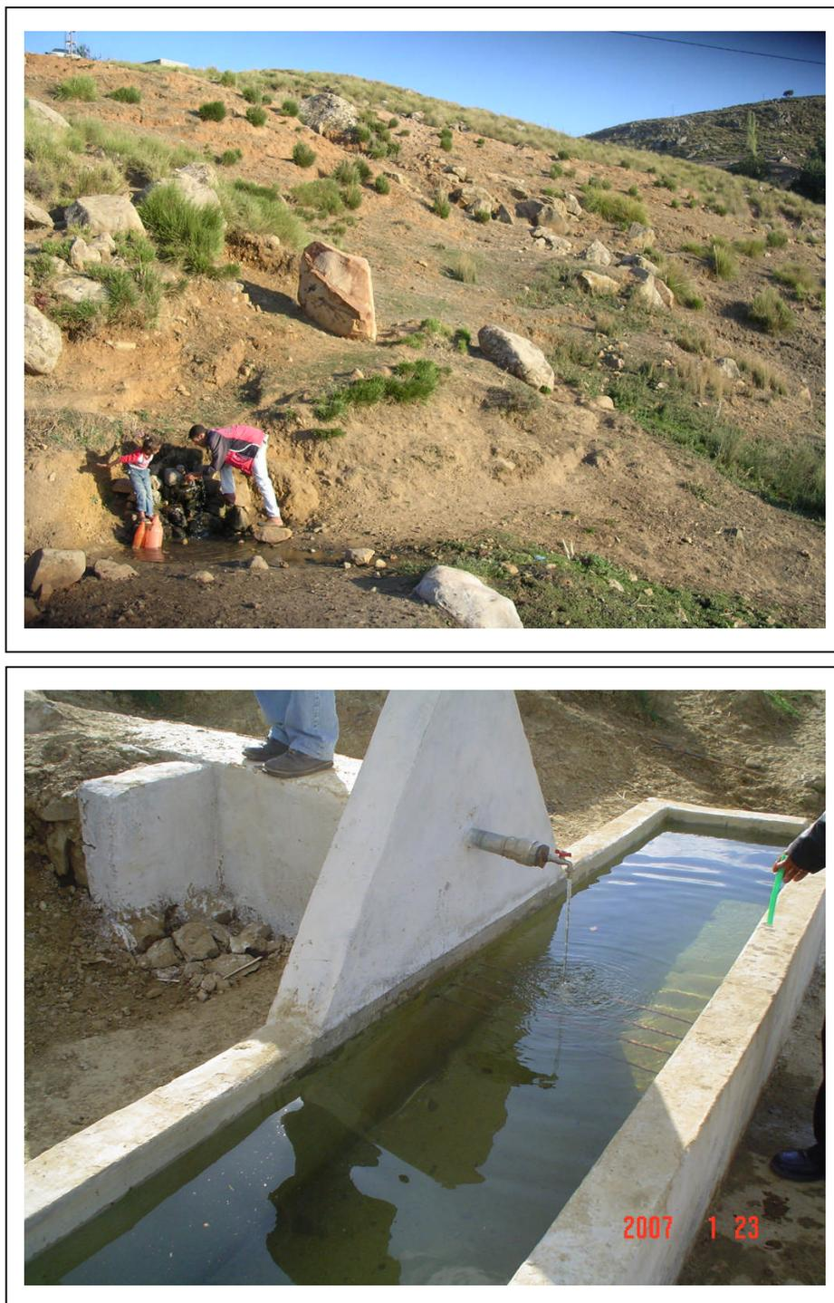
Figure.43. Alimentation en eau potable dans le milieu rural à partir des sources captées en amont du bassin du Saf-Saf.
