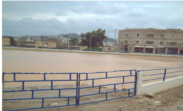
Bassin de rétention de Zaafrania
