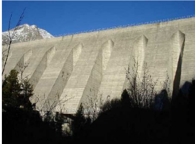
Figure 1.6 : Barrage poids à contreforts de Plan d'Amont (Aussois)
