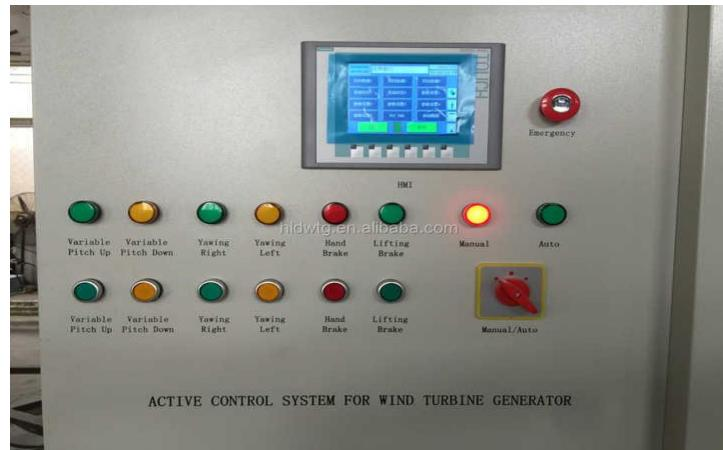
Figure I. 29 : Armoire de commande d'une éolienne
