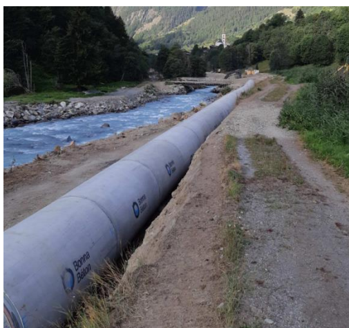
Fig.06 : Tuyau en béton précontraint sans âme tôle
