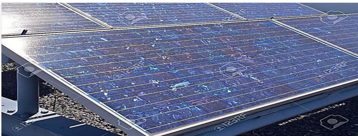
**Figure II.13** Cellule au silicium poly cristallin
