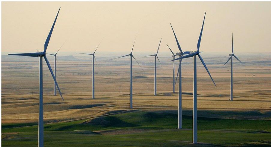
**Figure I.7:** Aérogénérateur à axe horizontal
