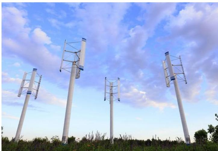
**Figure I.6:** Aérogénérateur à axe vertical
