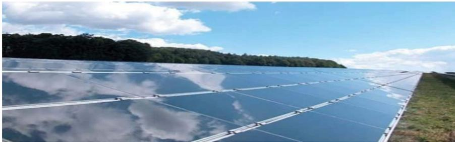
**Figure(II.5):** modules verre-verre au Telluride de Cadmium, efficacité de 9 à 11%
