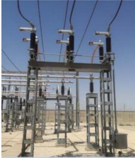
**Figure 0-2 sectionneurs**
