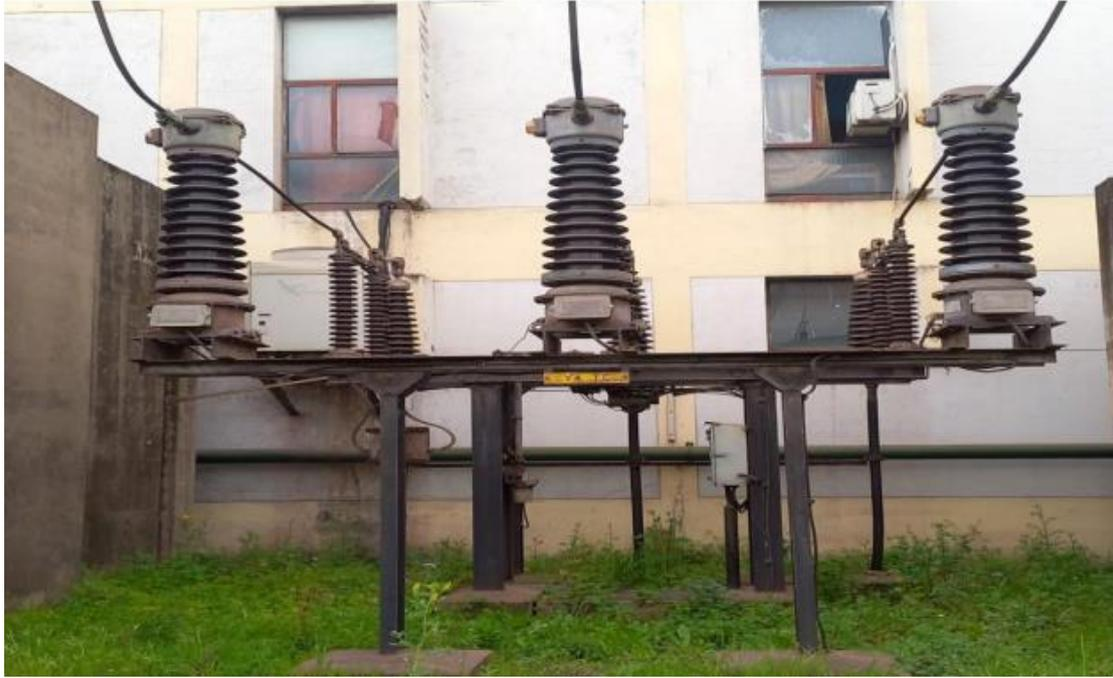
**Figure 0-8 Transformateur de courant.**
