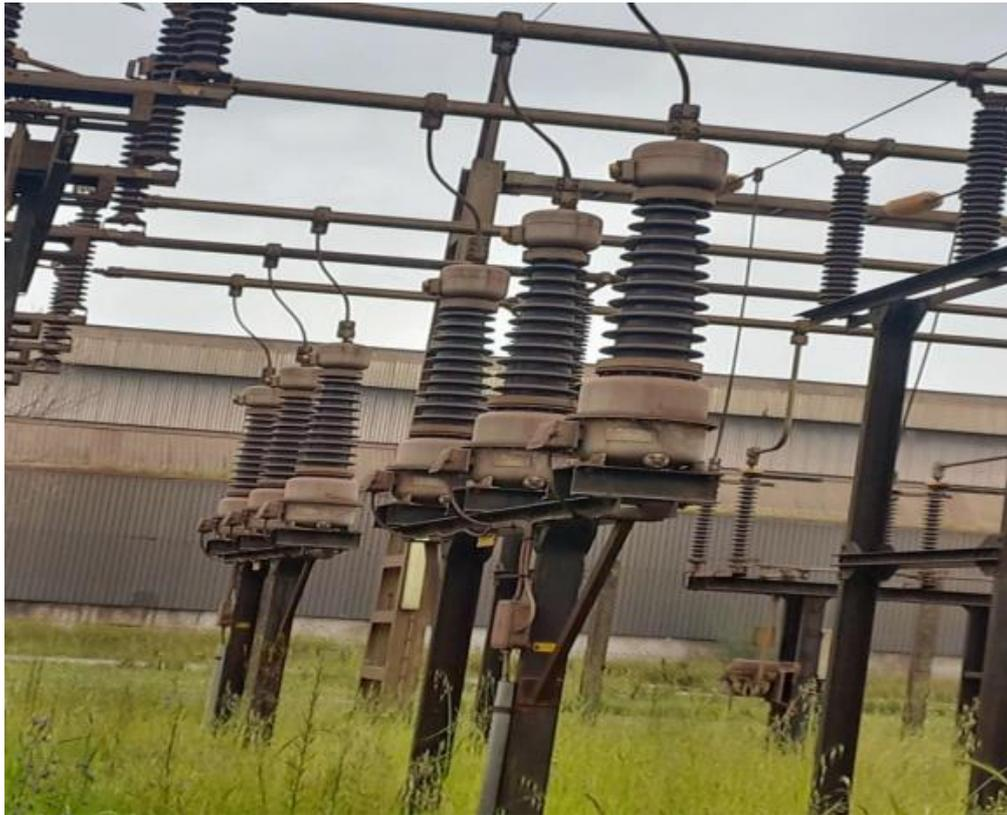
**Figure 0-9 Transformateur de tension.**
