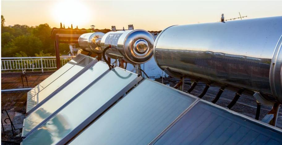
**Figure I.3. Panneau solaire thermique**
