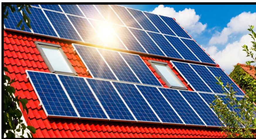
Figure I.17 : Energie solaire photovoltaïque.
