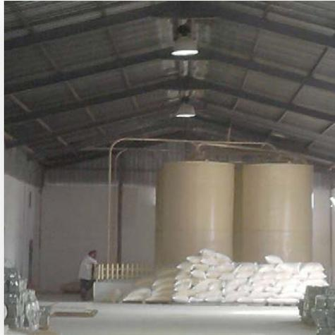
Fig.I.8: Les silos de stockage de la matière première
