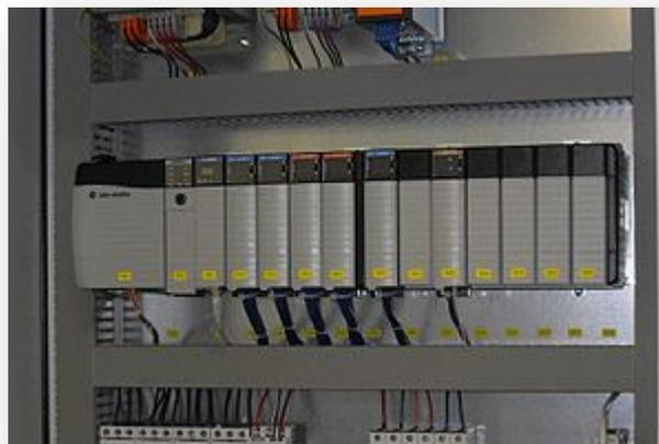
Fig.III.25. Automate dans une armoire électrique
