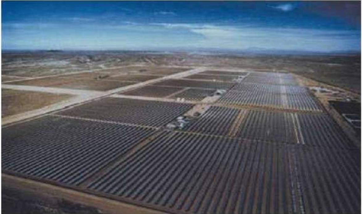
Figure 2.2 : Vue aérienne de 5 centrales SEGS en Californie [12]
