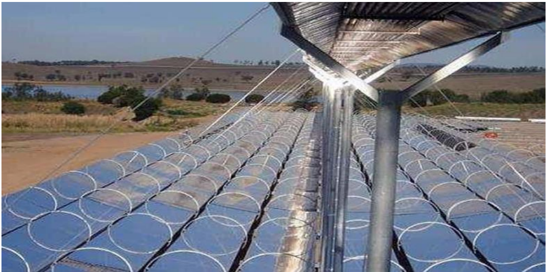
Figure 2.6 : Centrale solaire à miroir de Fresnel [11]
