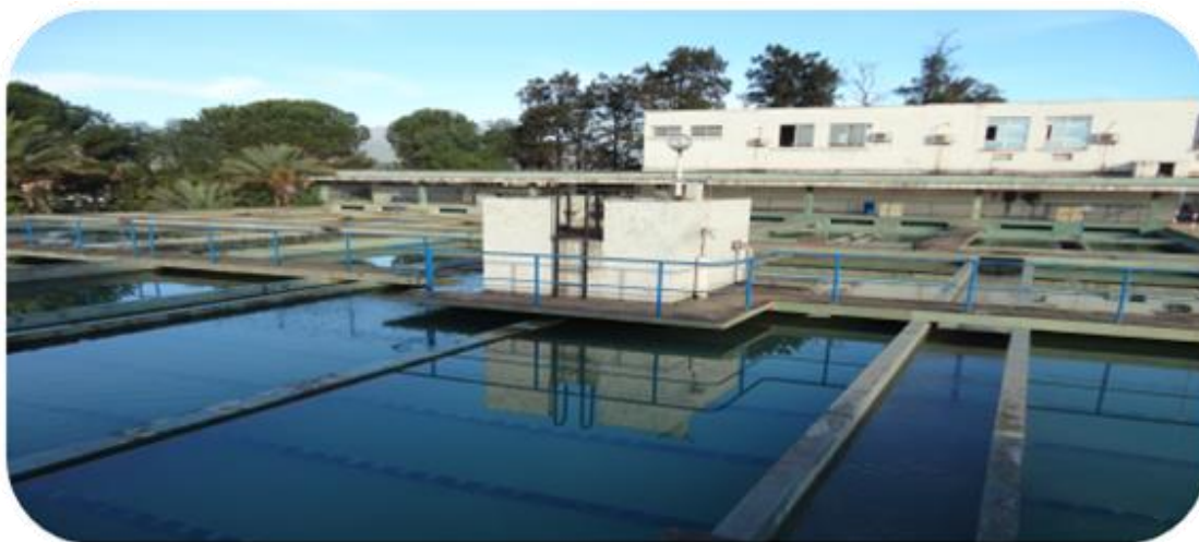
Fig III.6 – Décanteur pulsator station chaiba .
