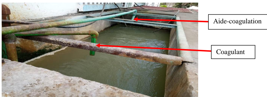
Fig. III.5 – Point d'injection du coagulant et de l'aide-coagulant
