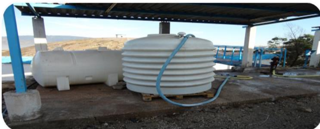
Fig III.4 – Réservoir de pré-chloration (hypochlorite de sodium) station chaiba.
