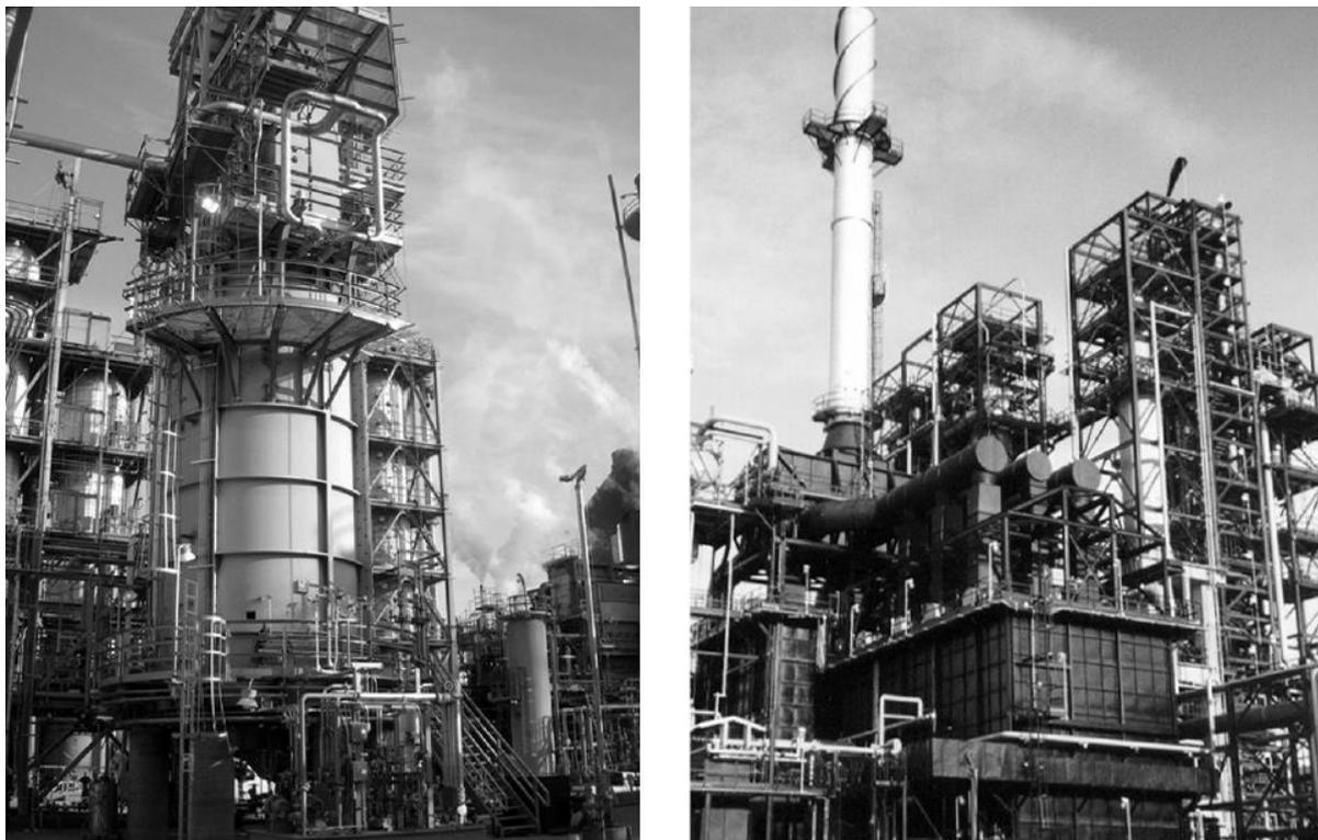
Figure 12 : Deux types de fours pétrochimiques montrant un four cylindrique (à gauche) et un four cabine
