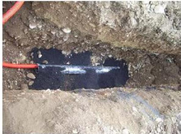
**Figure II. 5:** Pose d'une anode prébackfillée
