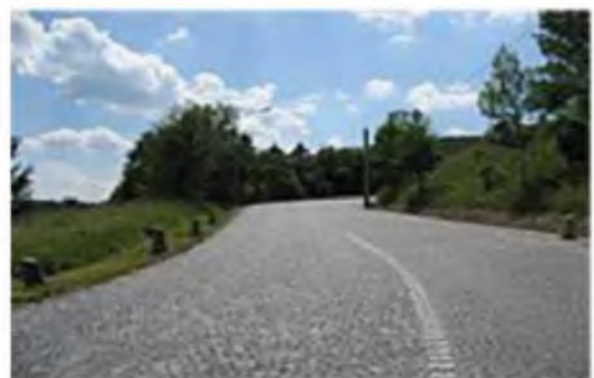
Figure II-9 : Le pavage non maçonné permet de diminuer le ruissellement, mais il est plus fragile et il y a risque de pollution si la nappe sous-jacente est vulnérable
