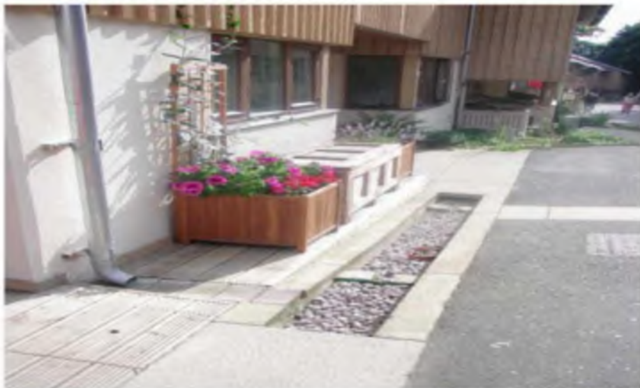
Figure I-8 : Vue d'une tranchée drainante devant une habitation [Bob Bray-7/2005].
