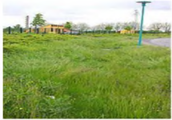
Figure II-7 : Cette noue absorbe les pics de ruissellement sans envoyer l'eau vers l'aval. Elle s'y infiltrera lentement dans le sol, en grande partie dépolluée par les plantes et les bactéries naturellement présentes.
