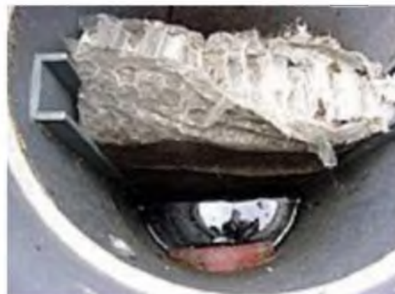
Figure II-5 : Un filtre en nid d'abeille, intégrée dans le réseau, pré-épure l'eau de ruissellement avant un stockage/infiltration en noue ou bassin végétalisé.
