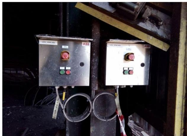
Figure III.2: boîtes de commande
