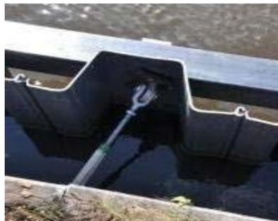
**Figure I.10 Palplanches laminées à froid.[8]**
