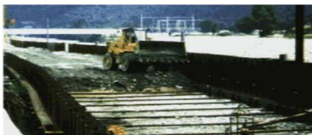
Figure I.13. Exemple d'un rideau partiellement fiché dans le sol[2]
