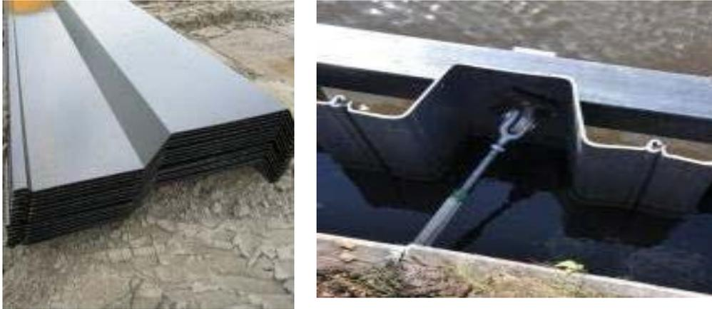
**Figure I.18 Palplanches laminées à froid.[12]**
