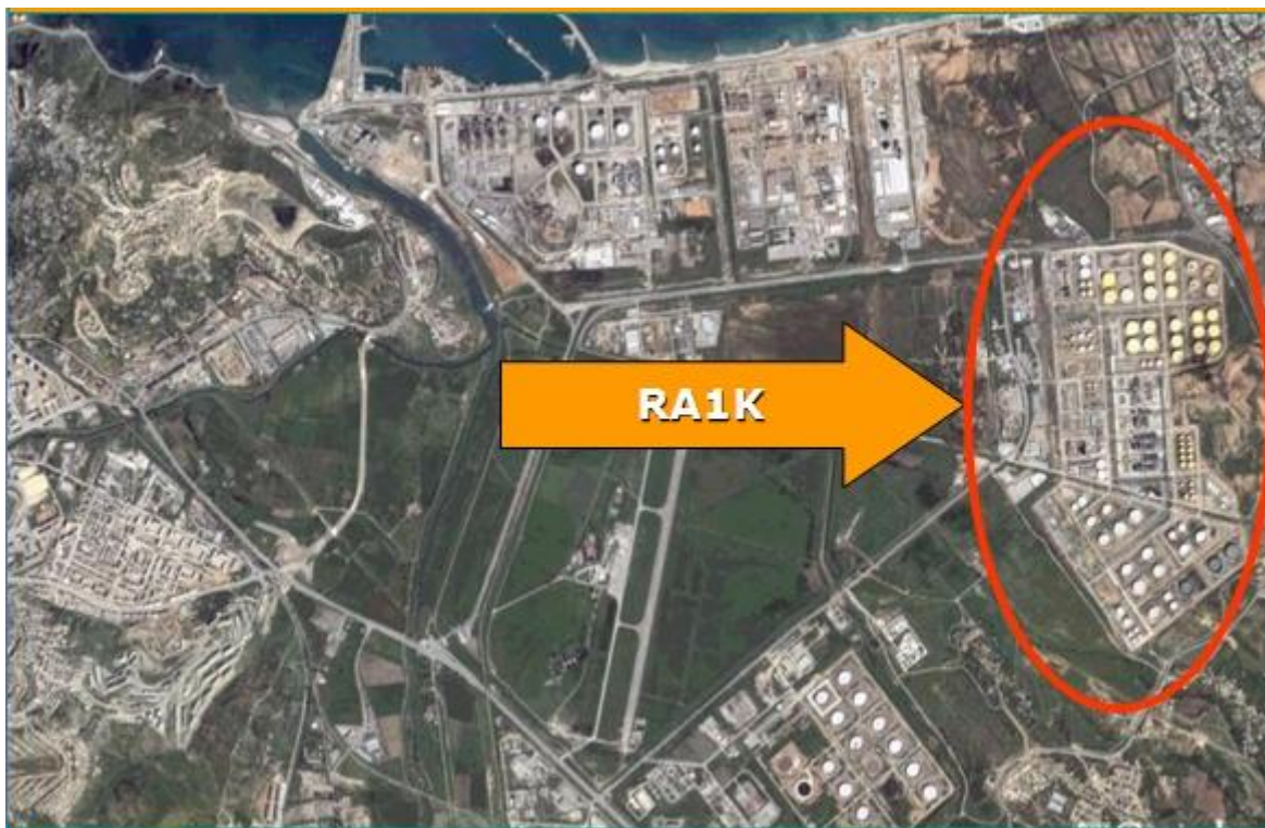
Figure 2 : Vue aérienne de la Zone Industrielle de Skikda
