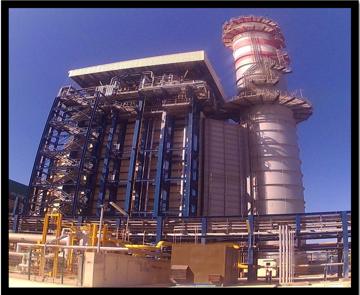
Fig 1.12.A : chaudière de récupération
