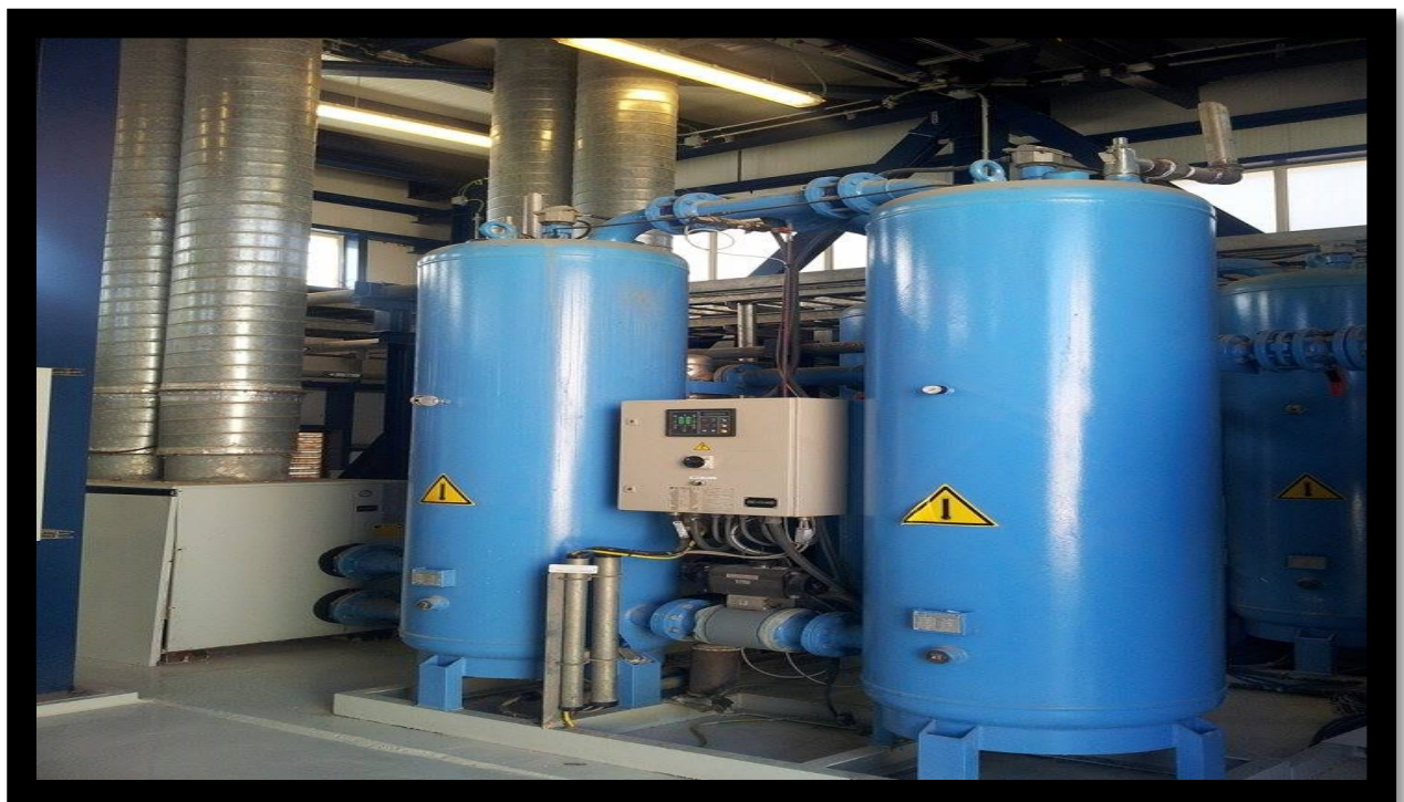
Fig 1 .16-B : Filtre sécheur
