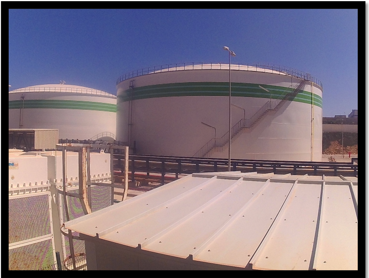
Fig 1.18 : bache de stockage d'eau de service
