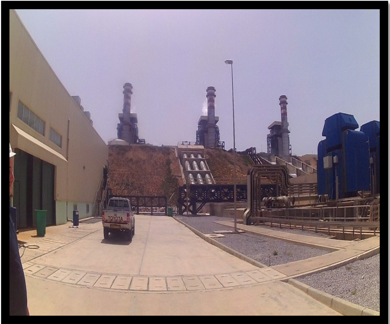
Fig 1.3 : les trois tranches de la centrale
