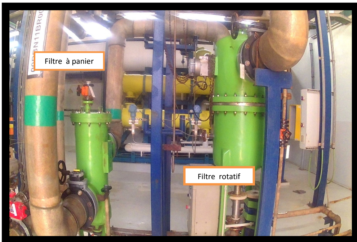
Fig 1.15-B : des filtres
