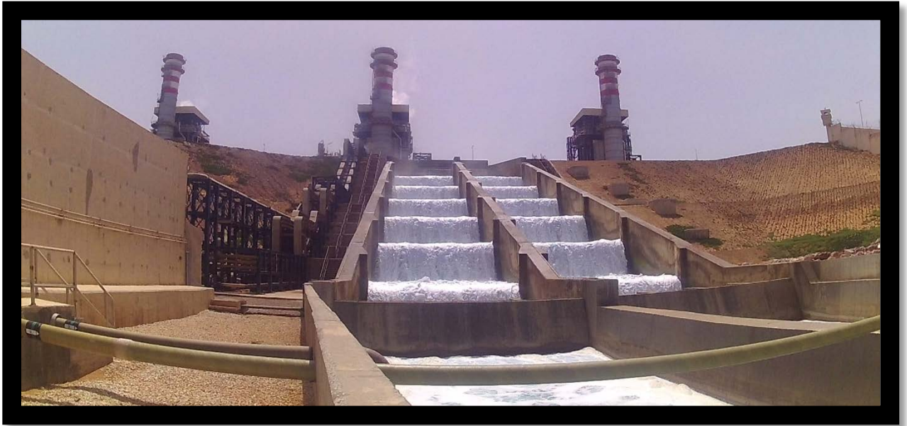
Fig 1.22 : canal de rejet
