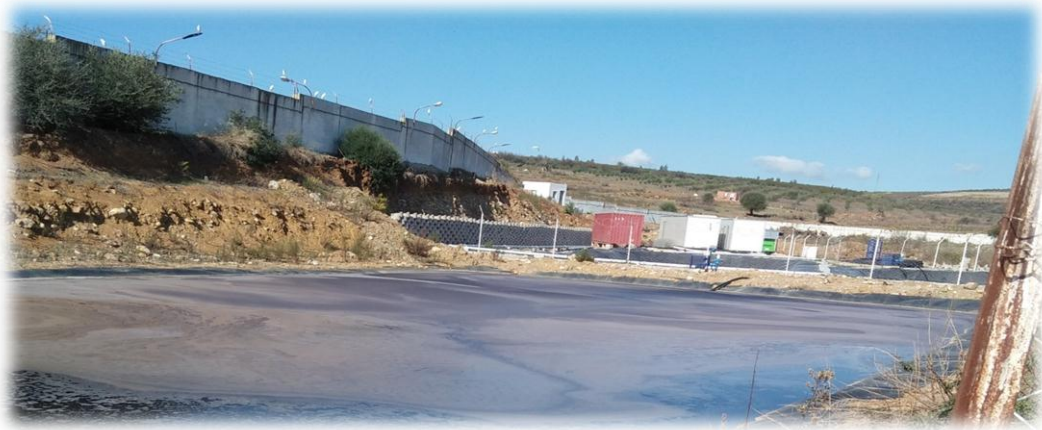
Figure 8 : Station de traitement des lixiviat du CET Bouguerguer Guelma ( Kaizouri, 2020 ).
