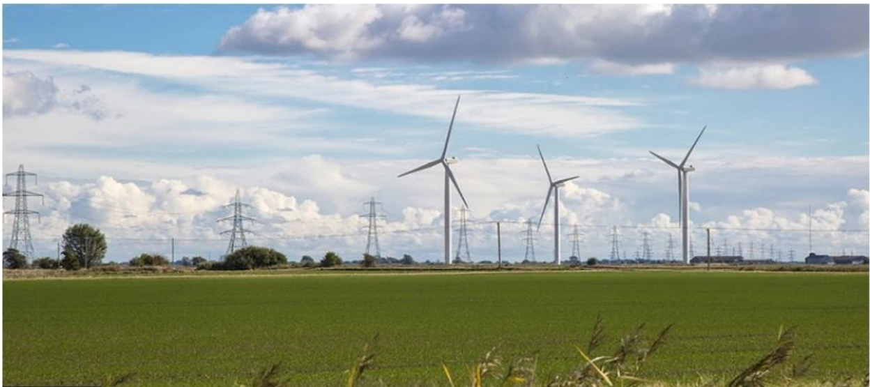
Figure 1.10 Éoliennes connectées au réseau [20].
