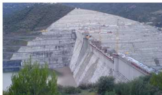
B BARRAGE DE KOUDIAT ASSERDOUN
