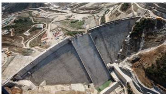
A BARRAGE DE TABELLOUT
