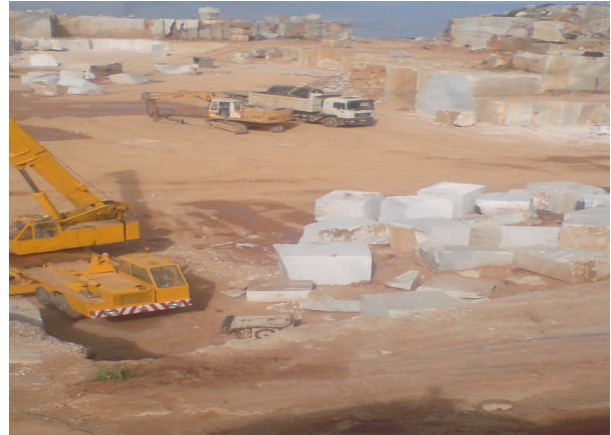
Figure 10. Chargement des blocs vers le lieu de traitement
