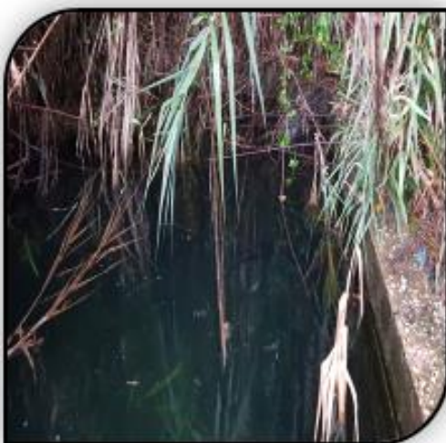
c- Bassin d'eau
