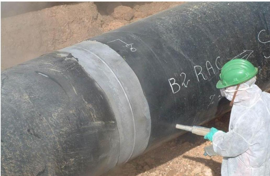
**Figure I.3.** Mise en place des revêtements sur le pipeline.
