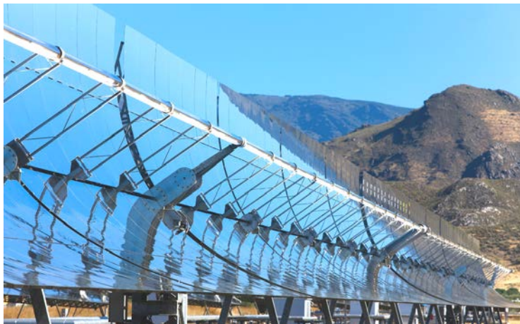
Figure 1.5 Centrale à auge parabolique de 50 MW avec stockage thermique à Andasol. Espagne [49]
