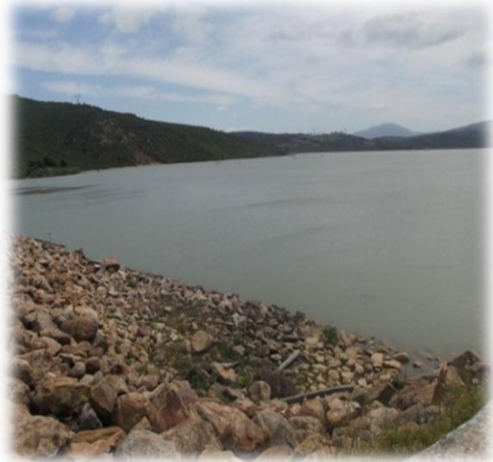
Fig.30. La digue de barrage à matériaux Locaux
