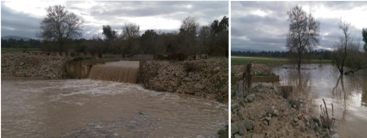
Fig.63. Ouvrage annexe oued Lahmar- Berrihane.
