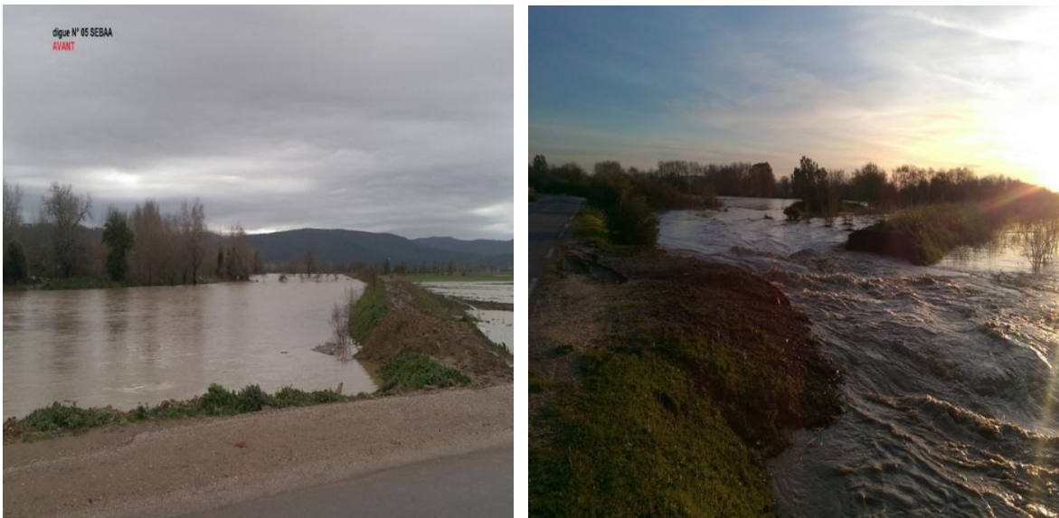
Fig.64. Digue N° 05 Sebaa
