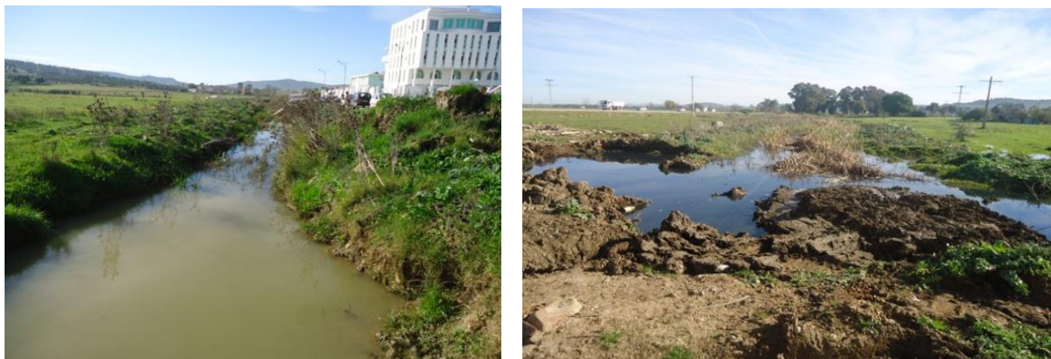
Fig.51. Avant l'aménagement du canal traversant la ville d'EL Tarf
