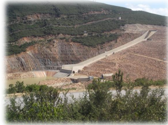
Fig.32. Évacuateur bétonné de Barrage Bougous
