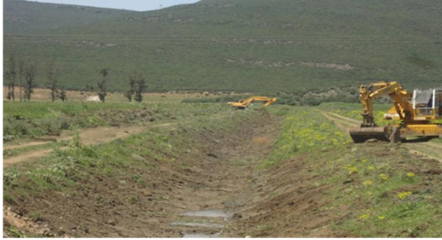
Fig.42. Curage Des Fosses De Drainage De La Plaine
