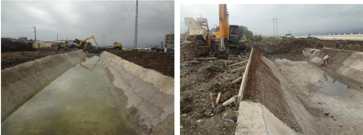
Fig.50. Travaux D'aménagement Du Canal De BEN AMAR-
