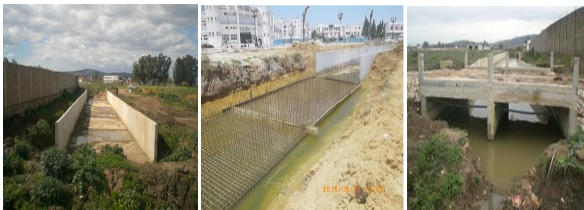
Fig.52. Aménagement du canal en cours traversant la ville d'EL Tarf
