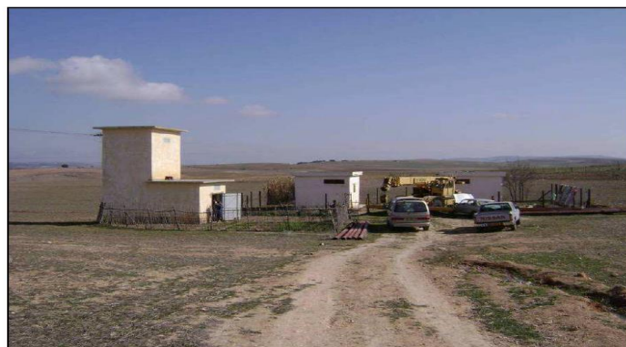
Photo 2.6 : Local abritant la fontainerie du forage D'4
