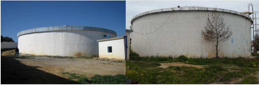
Photo 2.11 : Réservoir Hôpital régional
