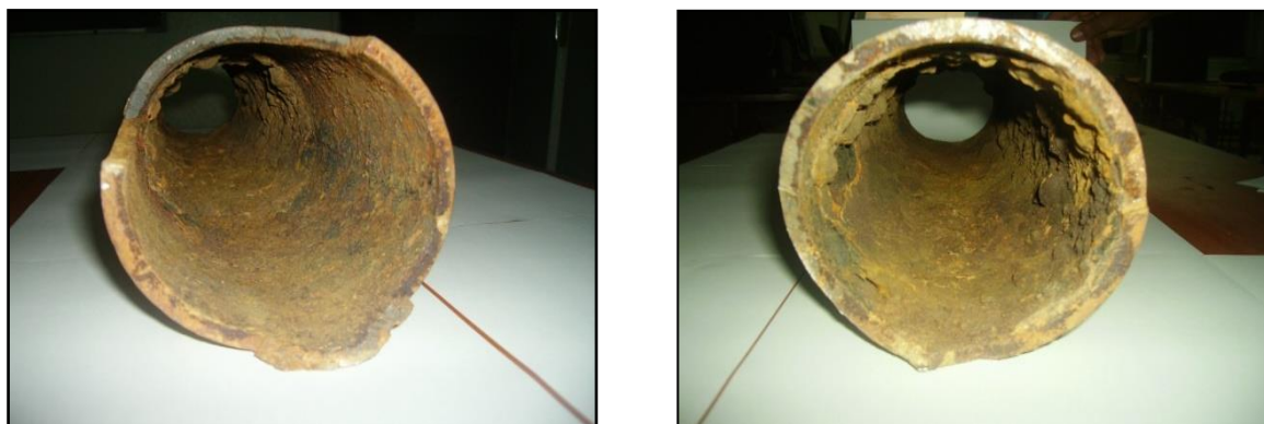
Photo 3.5 : Échantillon prélevé lors de la rénovation du réseau d'AEP ville de S/Ahras, Caractéristiques de matériau : tronçon de 50 cm en fonte ductile (DN100mm ep7mm).
