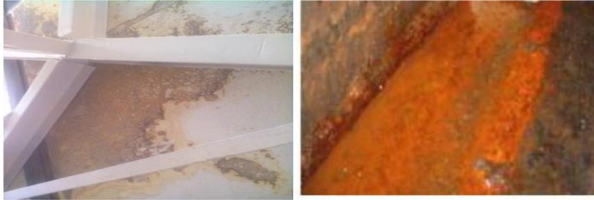
**Figure 2.14 :** Exemple de corrosion d'un bac de stockage (cas du dépôt de stockage de Sidi Rcine–Alger)
