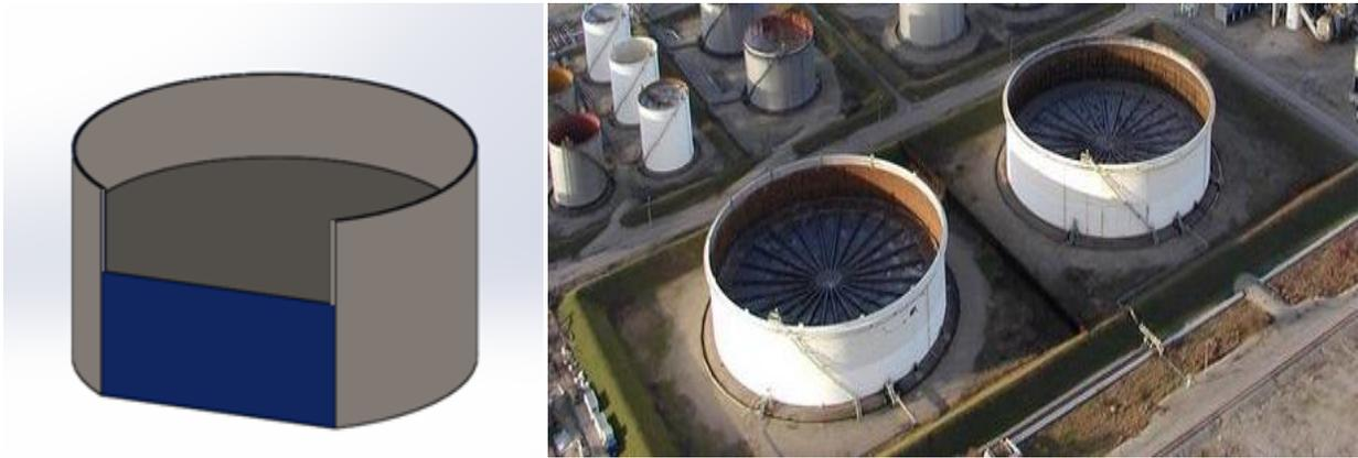
**Figure 1.9 :** Réservoirs à toit flottant externe (*Les Industries, 2020*)
