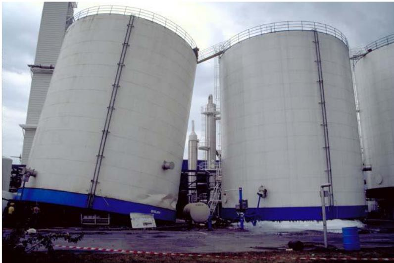
**Figure 2.15 :** Tassement dû au tremblement de terre de d'Izmit, (Turquie 1999) (Partie, 2014)
