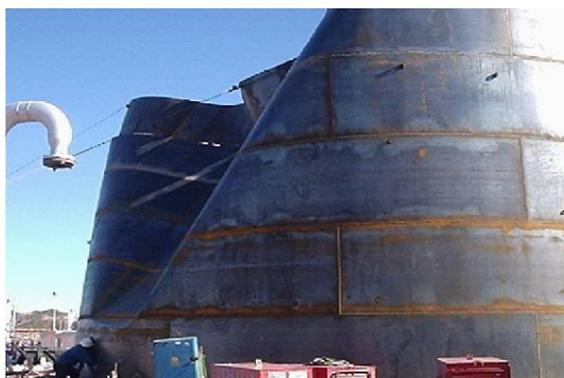
**Figure 2.18 :** Déformation d'un bac à Rincon de los Sauces2006 à cause du vent, selon (Jaca & Godoy, 2010)
