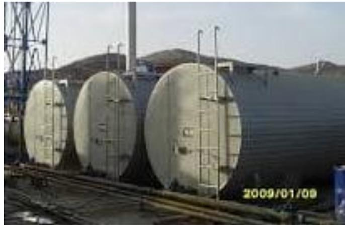
Figure 1.6 : Les réservoirs à évente
