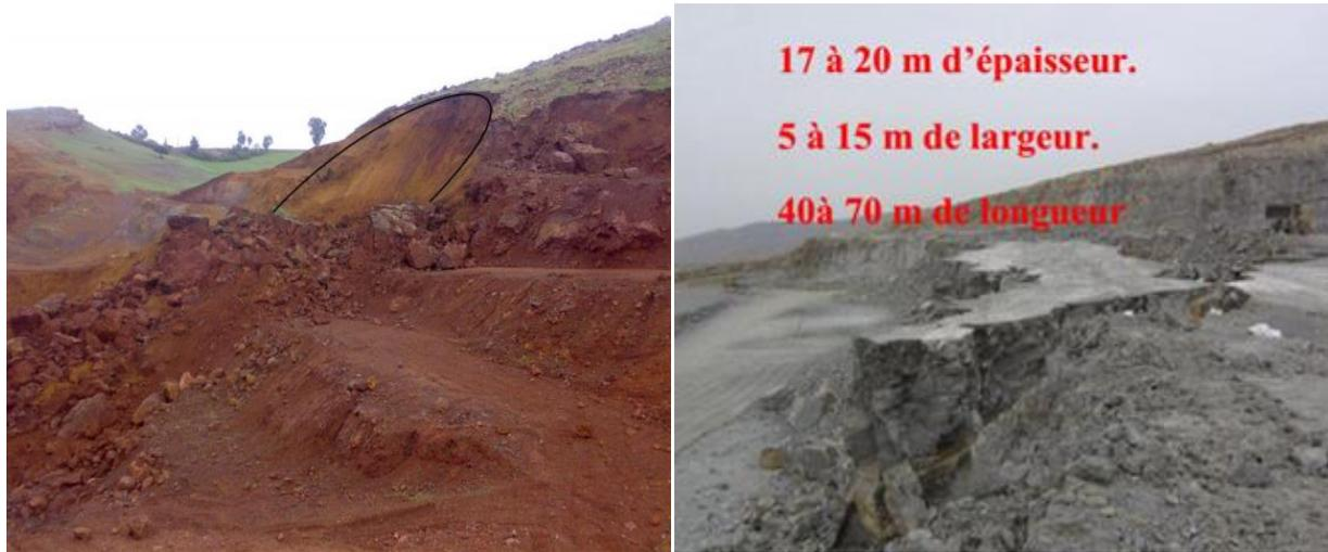
**Figure II. 9.** Glissement de la mine de fer de Rouina (W. Ain Defla) 2012
