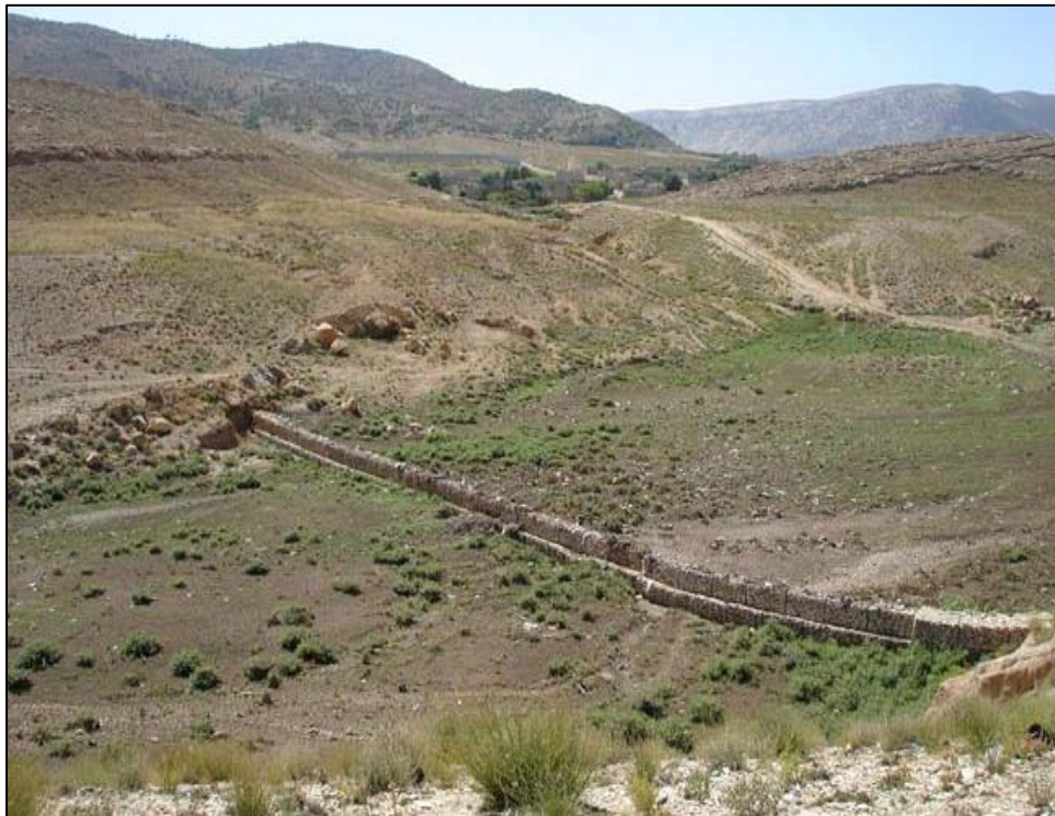
Photo 6. Barrage de correction torrentielle à Tébessa
