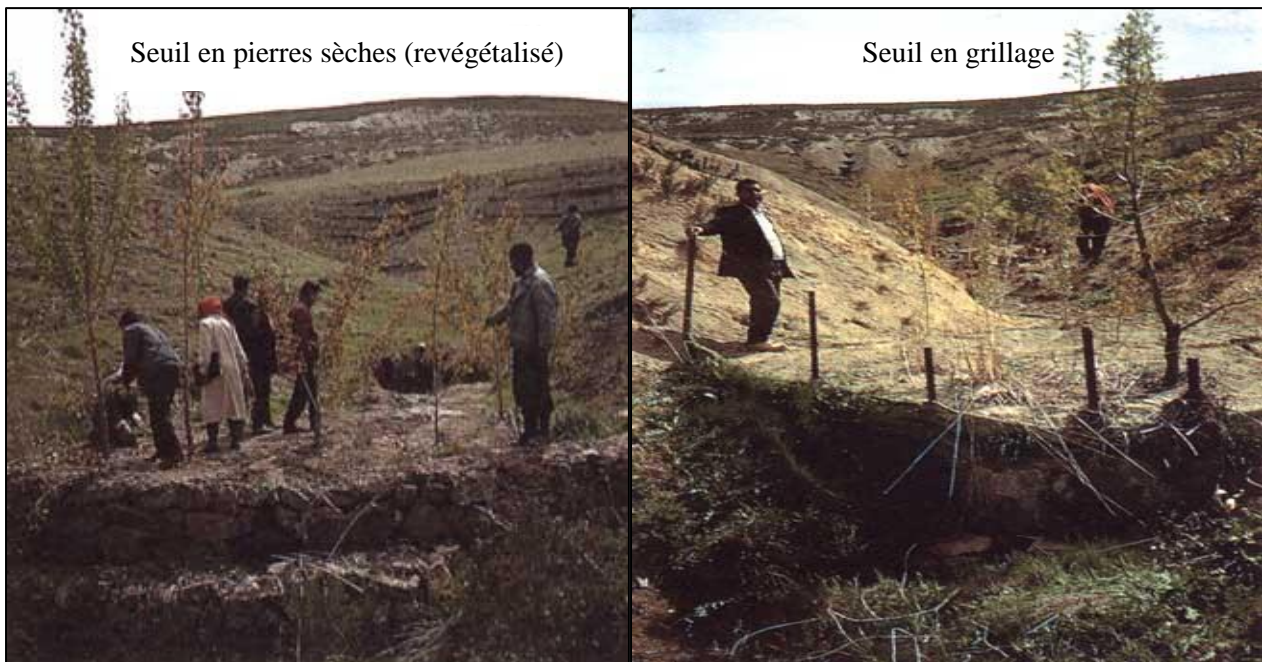
Photo 5. Exemple de seuils à Souagui, Algérie (d'après la FAO).
