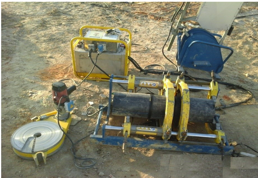
Figure. 2.1 : Opération de soudage b-à-b sur chantier
