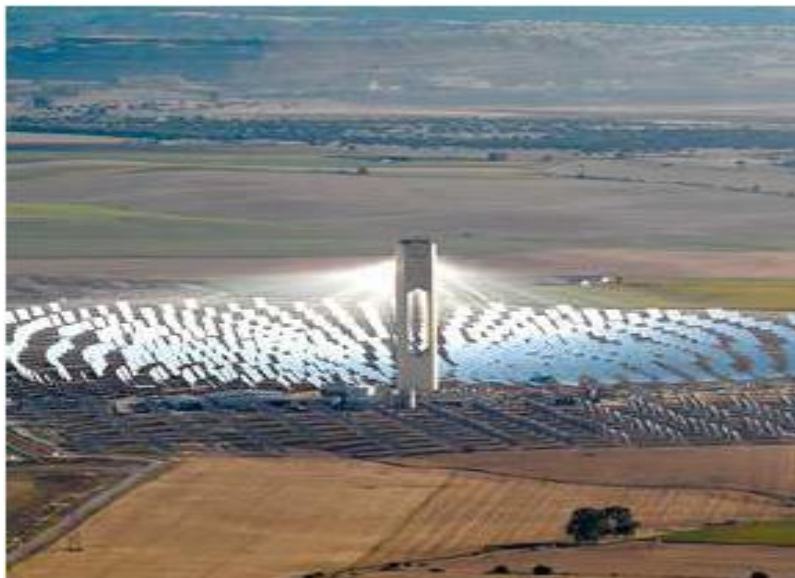
Figure 1.14 : Centrale à tour solaire [44]
