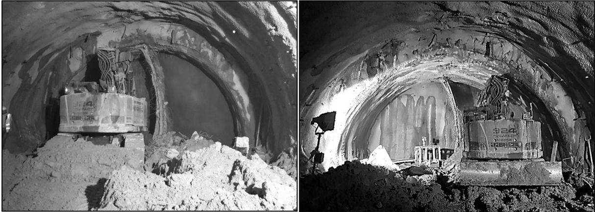
**Fig.3.09** : attaque du front de la taille (Calotte I et Calotte II)
