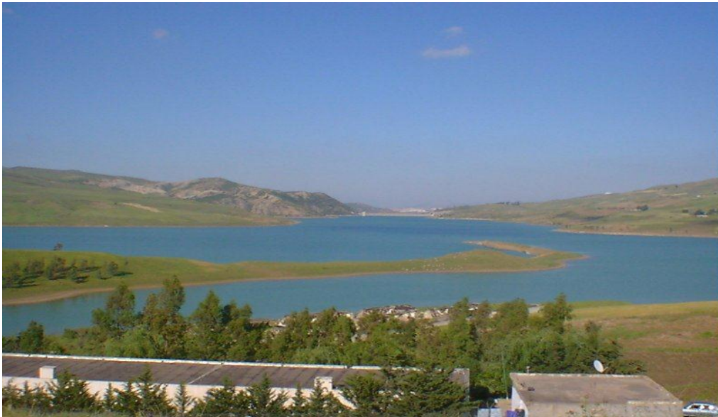
Fig.13. Vue générale du barrage d'Ain Dalia (ANBT 2013).
