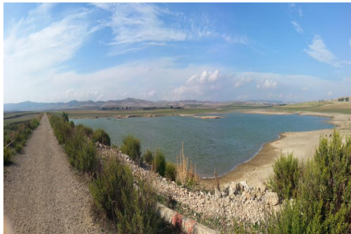
Fig.4. Vue générale de La retenue collinaire de Tiffech (Photo Benradia. M)
