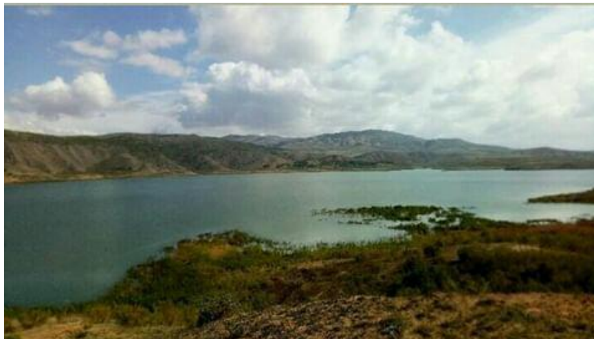
Fig.11. Vue générale du barrage Foug El-Khanga (photo Benradia. M).
