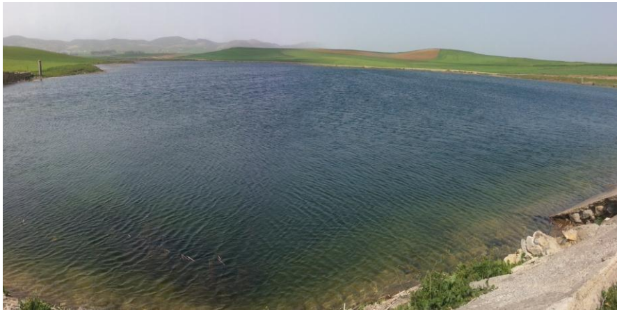
Fig.5. Vue générale de La retenue collinaire d'El Kef (Photo Benradia. M)
