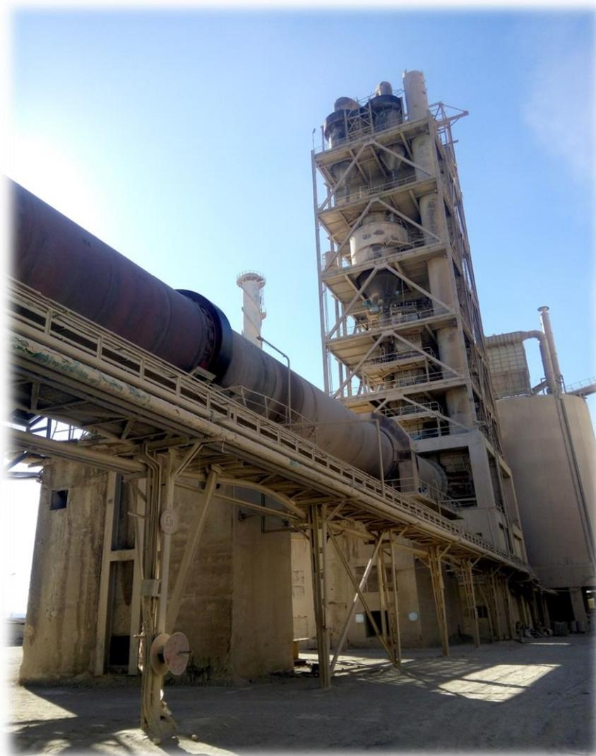
*Figure II.3 : Le four rotatif et le tour échangeur (Cimenterie Hadjar-Soud)*
