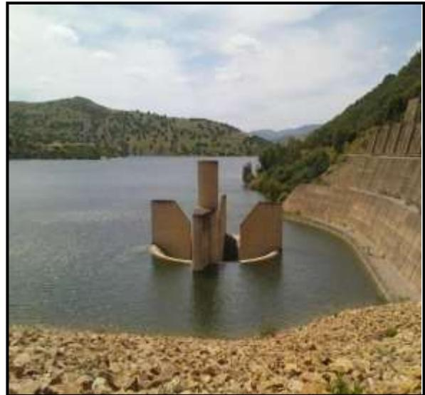
**Photo.III.1:** Barrage Hammam Debagh : évacuateur de crues en puits de section circulaire et protection sur la rive gauche (vue à partir de la digue) (mai 2012)
