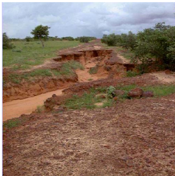
Figure 12. Erosion en rigole.
