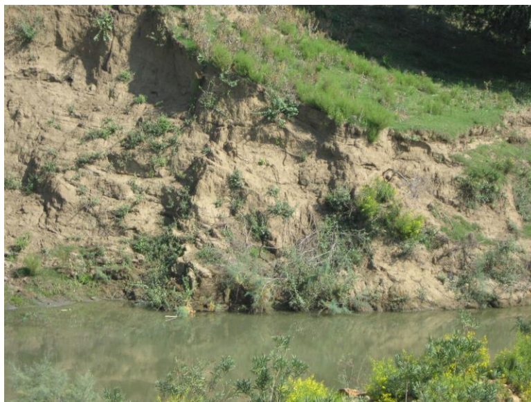
Figure 74. Sapement de berge et glissement de terrain au niveau de l'Oued Bougous.
