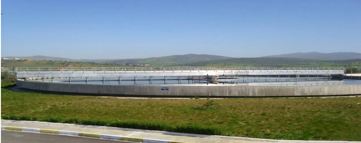
Figure.64 : Bassin de décantation secondaire(Clarificateur).
