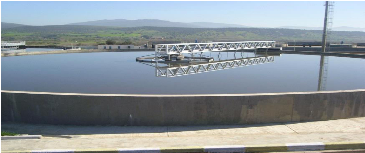
Figure. 62 : Bassin de décantation primaire (décanteur).
