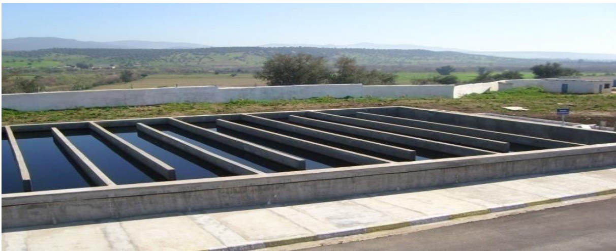
Figure.66: Sortie de la STEP (bassin de désinfection).
