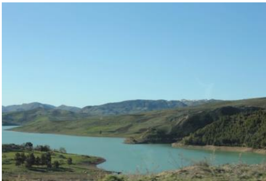
Photo I.1 : Barrage Ain Dalia
