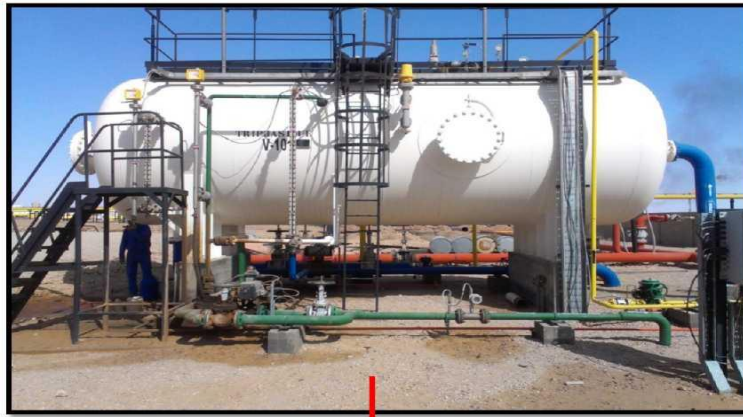
Figure (IV.26) : le séparateur tri-phasique.
