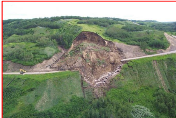
Photo 3. Glissement de terrain sur la route du lac Cecil, Peace River. (Cliché : Couture)
