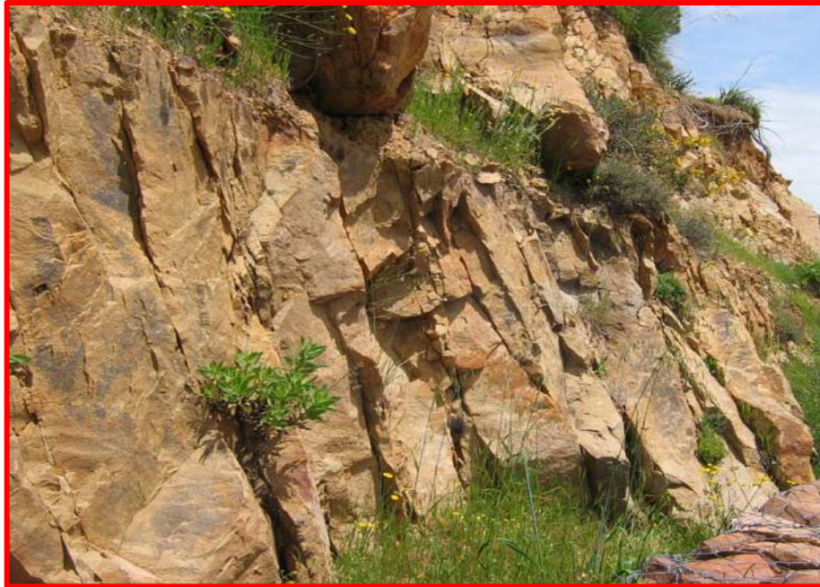
Photo 6. Grès Oligocènes très fracturés (photo prise pendant les études de l'avant-projet détaillé dans la section étudiée. Source : ANA, 2007)
