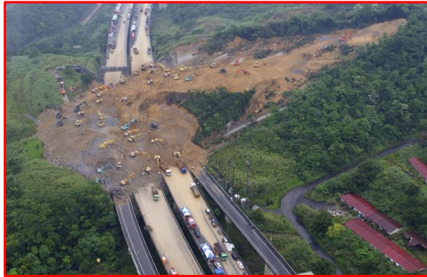
Photo 5. Coulée boueuse, Autoroute de Taïwan, 2010
