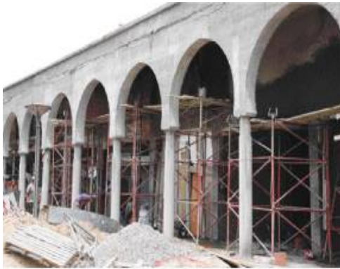
Les travaux de réhabilitation de la galerie commerciale (sur l'avenue des FAR près de Bab Marrakech) sont avancés à hauteur de 30%. Une trentaine de commerçants verront bientôt leurs locaux réaménagés harmonieusement
