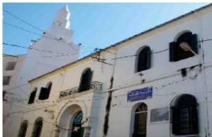
Fig. 60 : Photographie de la mosquée Abou Marouane.
