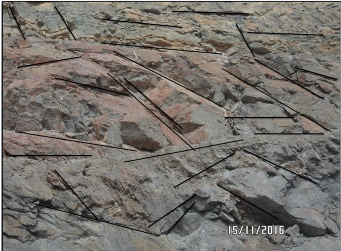
Figure 4.14 : Fissures et zone fracturée affectant la carrière ENOF.
